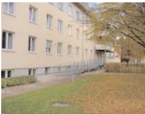
Barrierefreier Gartenzugang Fotos: SWW
